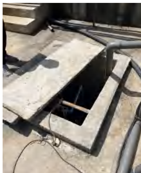
收集池1（地下池体）
