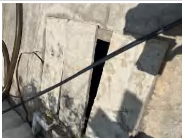
收集池 2（地下池体）
