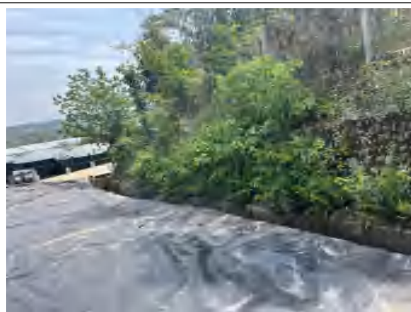
填埋库区截洪沟
