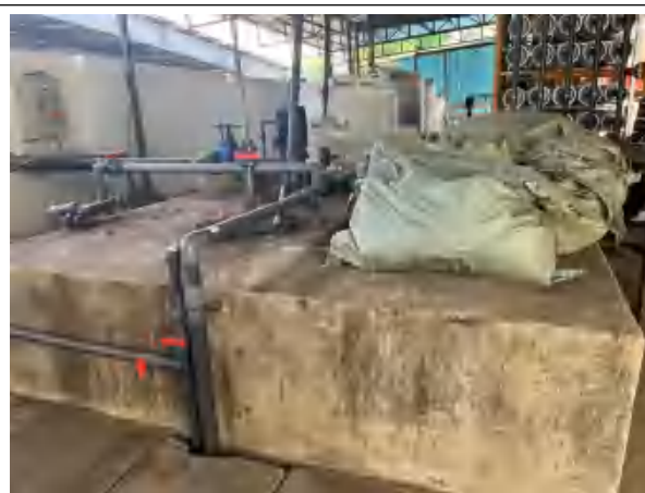
污泥池（半地下池体）
